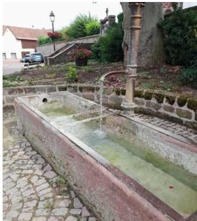
Travaux d'entretien et de nettoyage de la fontaine de la place du Curé Bertomé
