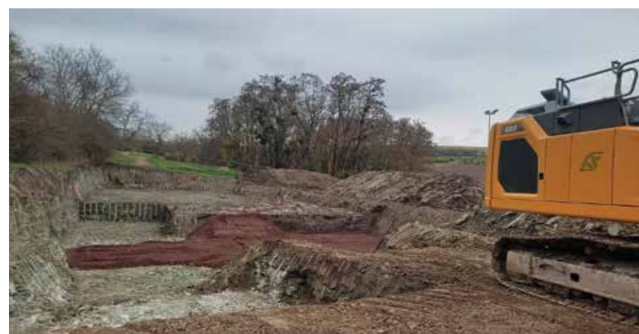
Travaux de terrassement
