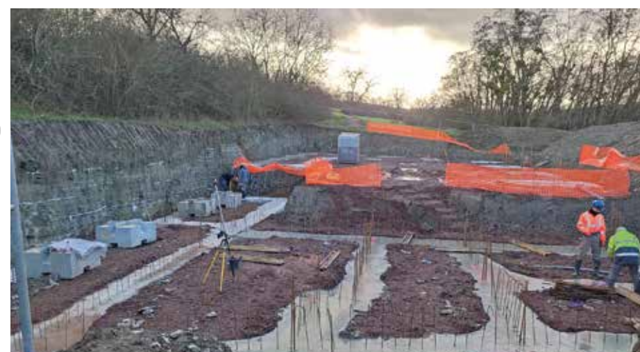
Les fondations : l'assise du futur bâtiment
