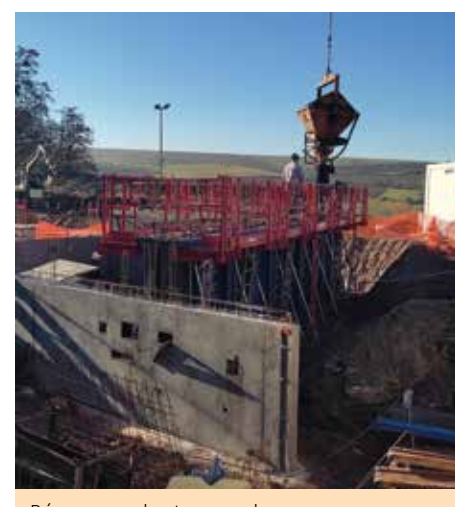
Démarrage des travaux de gros-œuvre : les premiers murs
