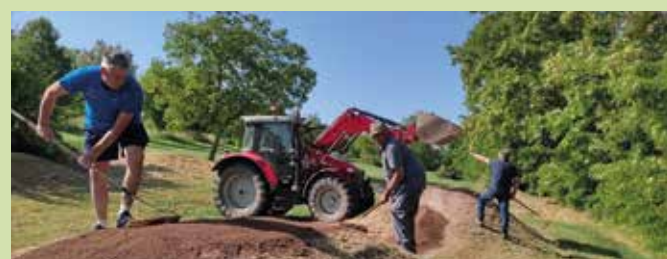
Remise en état du dirt
