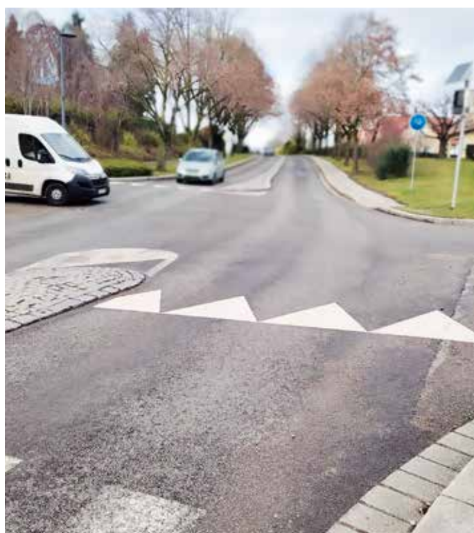
Ajout de marquage au sol matérialisant les priorités à droite de la rue principale de Willgottheim
