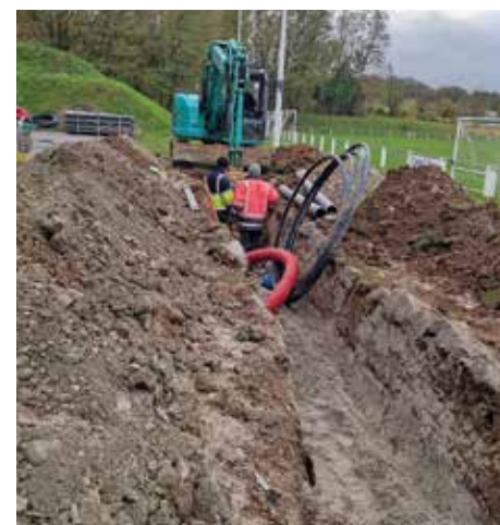
Pose des réseaux depuis la rue principale en cheminant le long du terrain de football
