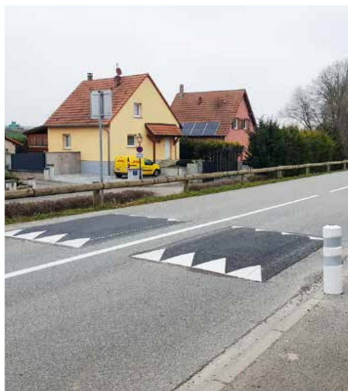
Installation de coussins berlinois à l'entrée de Woellenheim en venant de Rohr afin de ralentir la circulation dans le village
