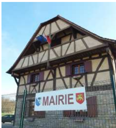
Mairie provisoire durant les travaux
